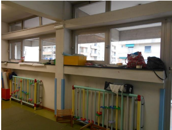
Figura 2.2 - Particolare dei serramenti
