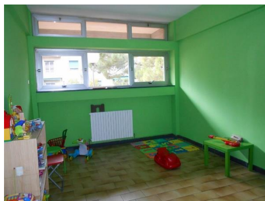
Figura 2.1 - Particolare dei serramenti
