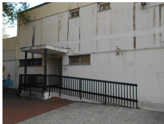
Figura 1.1 - Particolare della facciata principale d’ingresso (lato nord)
